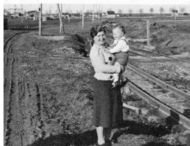
Am Bahnübergang an der Eggartenstraße/Feldbahnstraße
