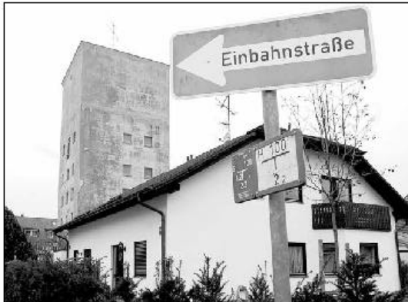
Richtung vorgegeben: Für den Lerchenauer Wasserturm an der Dahlienstraße 13 gibt es laut Stadt nur noch eine Lösung. Den Abriss. Foto: Marcus Schlap
