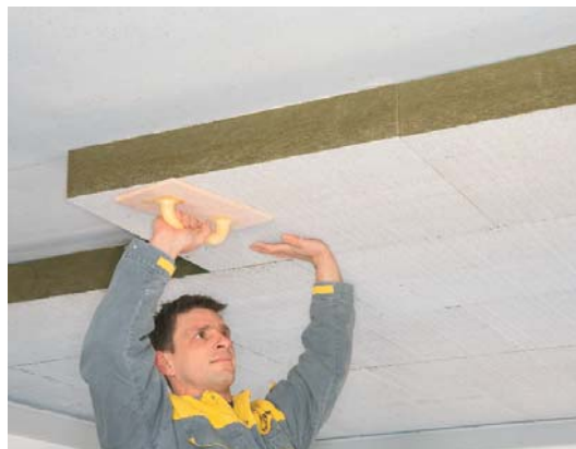
Das Dämmen der Decke oder des Dachbodens kann in bestimmten Fällen zur Pflicht werden
